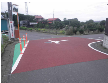
安全対策を実施した町道
