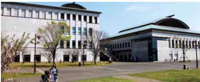
▲寒川総合体育館
