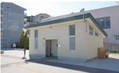
▲多機能洋式トイレが併設されている 寒川駅前公園のトイレ
