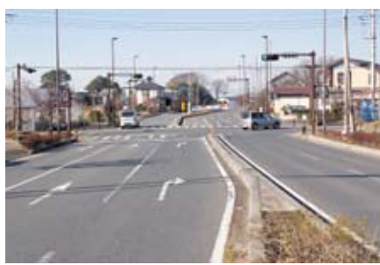
湘南台寒川線(藤沢市打戻地内)
