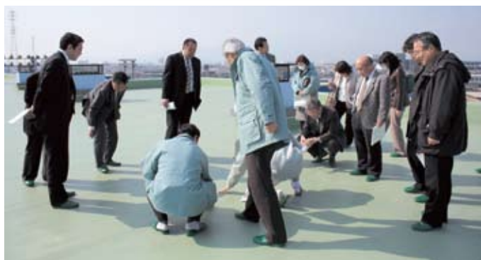
寒川中学校屋上で説明を受ける委員
