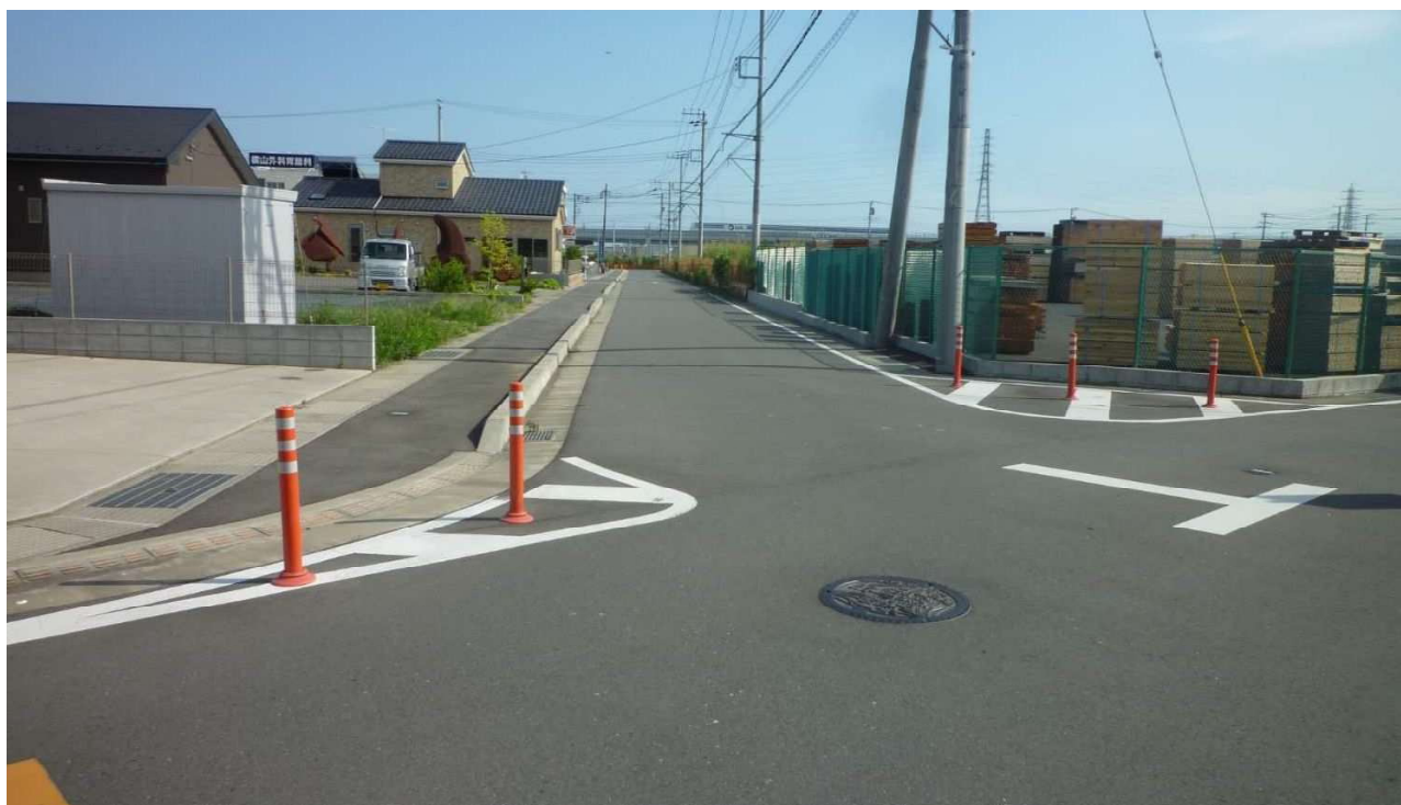
01012 田端 12 号線 現況写真 【終点→中間点】
