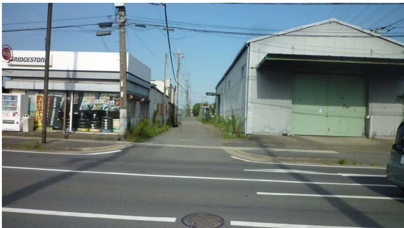
01021 田端 21 号線 現況写真 【終点→中間点】
