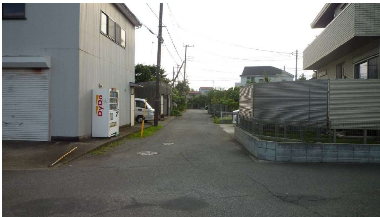
01035 田端 35 号線 現況写真 【起点→中間点】
