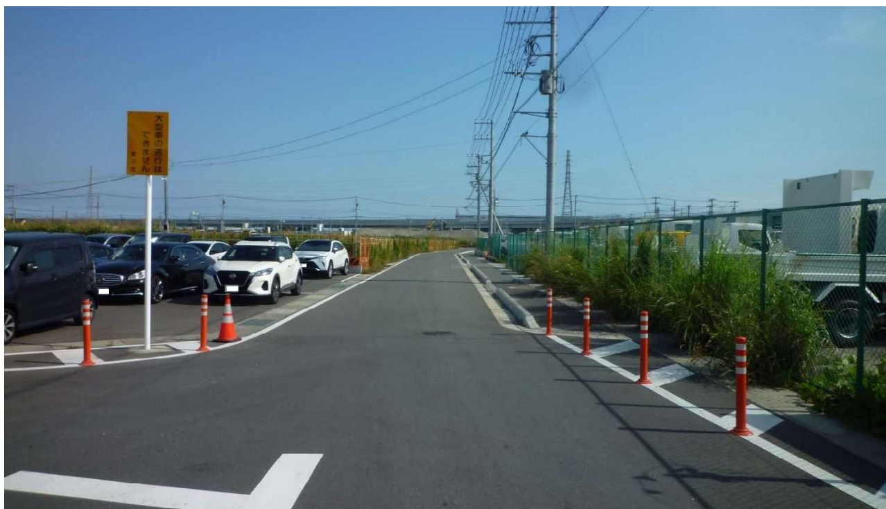
01013 田端 13 号線 現況写真 【終点→中間点】
