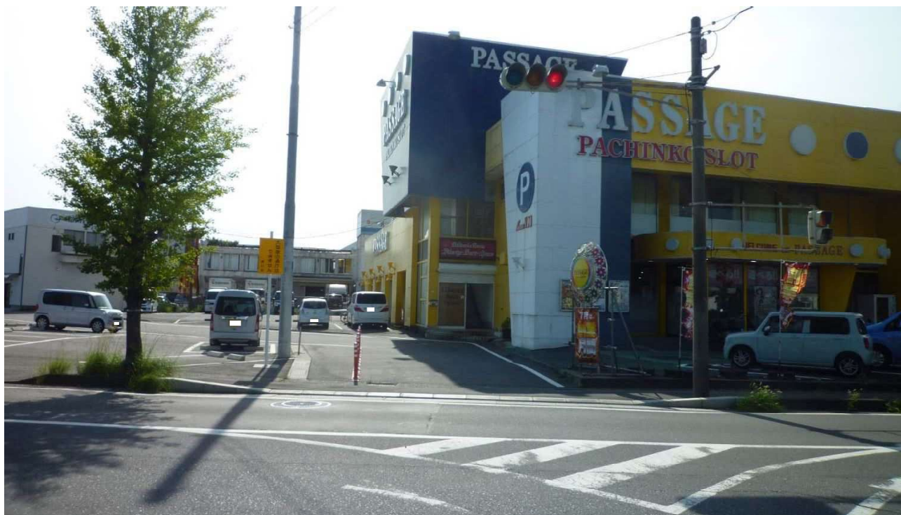
01039 田端 39 号線 現況写真 【起点→中間点】
