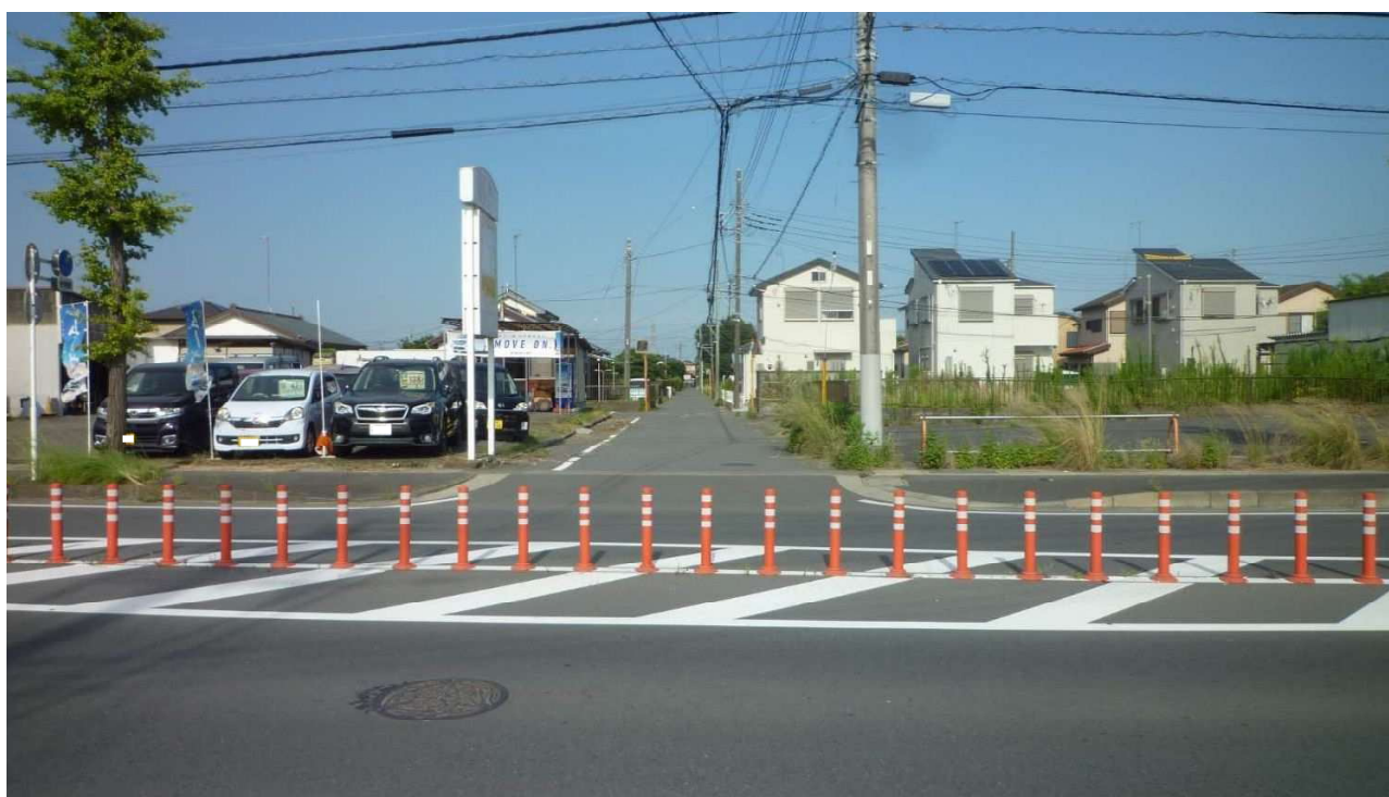
01020 田端 20 号線 現況写真 【終点→中間点】
