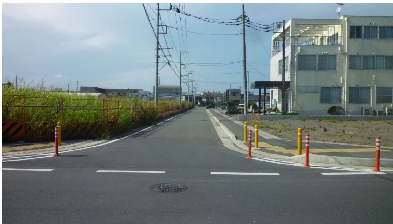
01012 田端 12 号線 現況写真 【起点→中間点】
