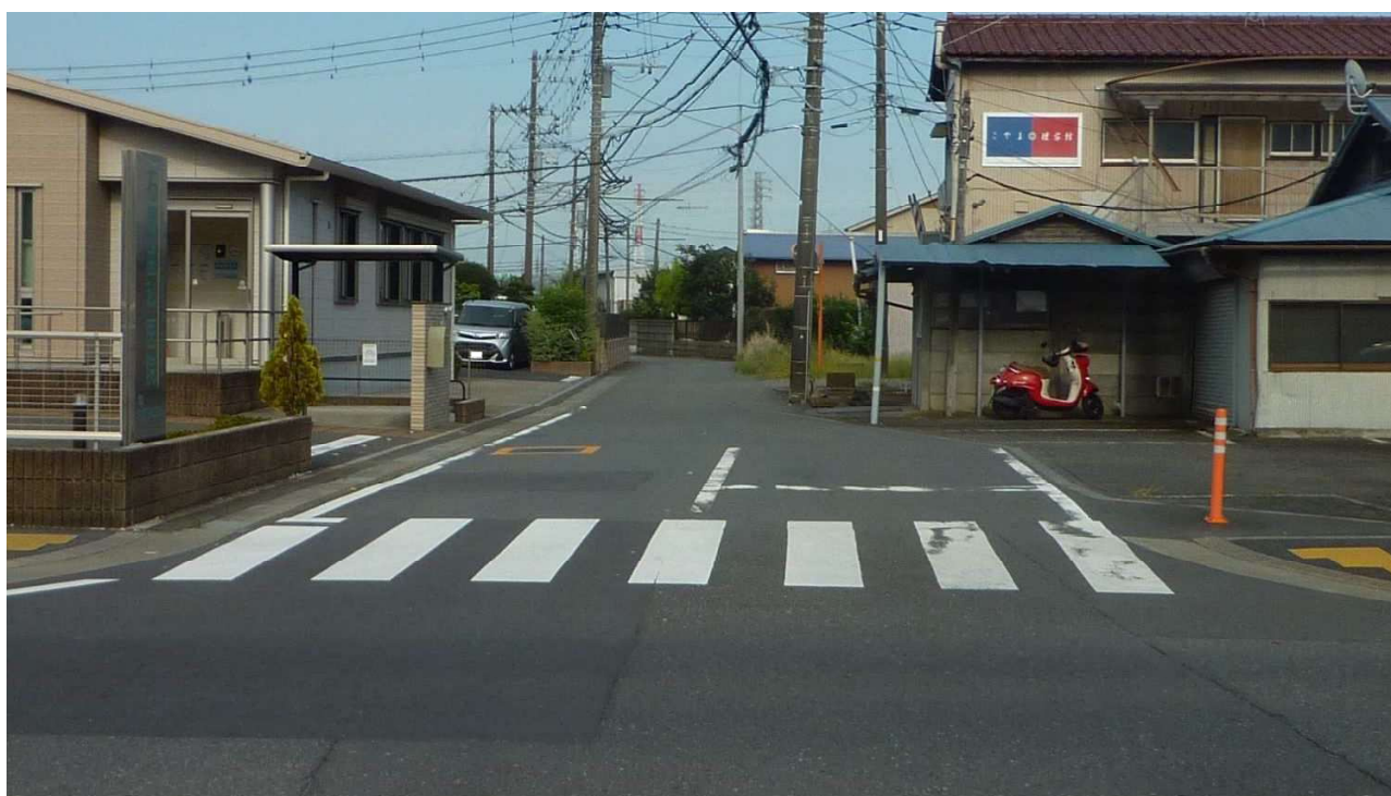
01007 田端 7 号線 現況写真 【終点→中間点】
