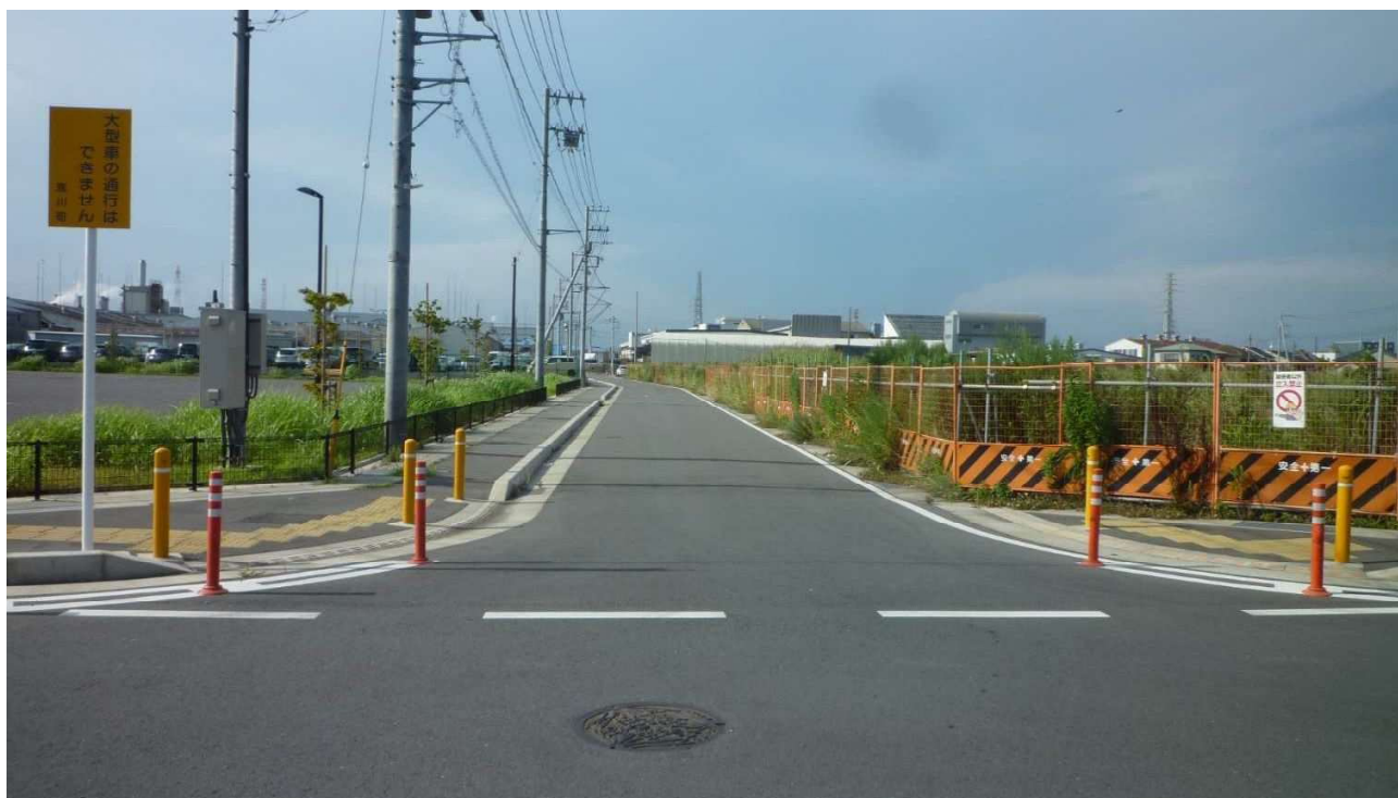
01013 田端 13 号線 現況写真 【起点→中間点】
