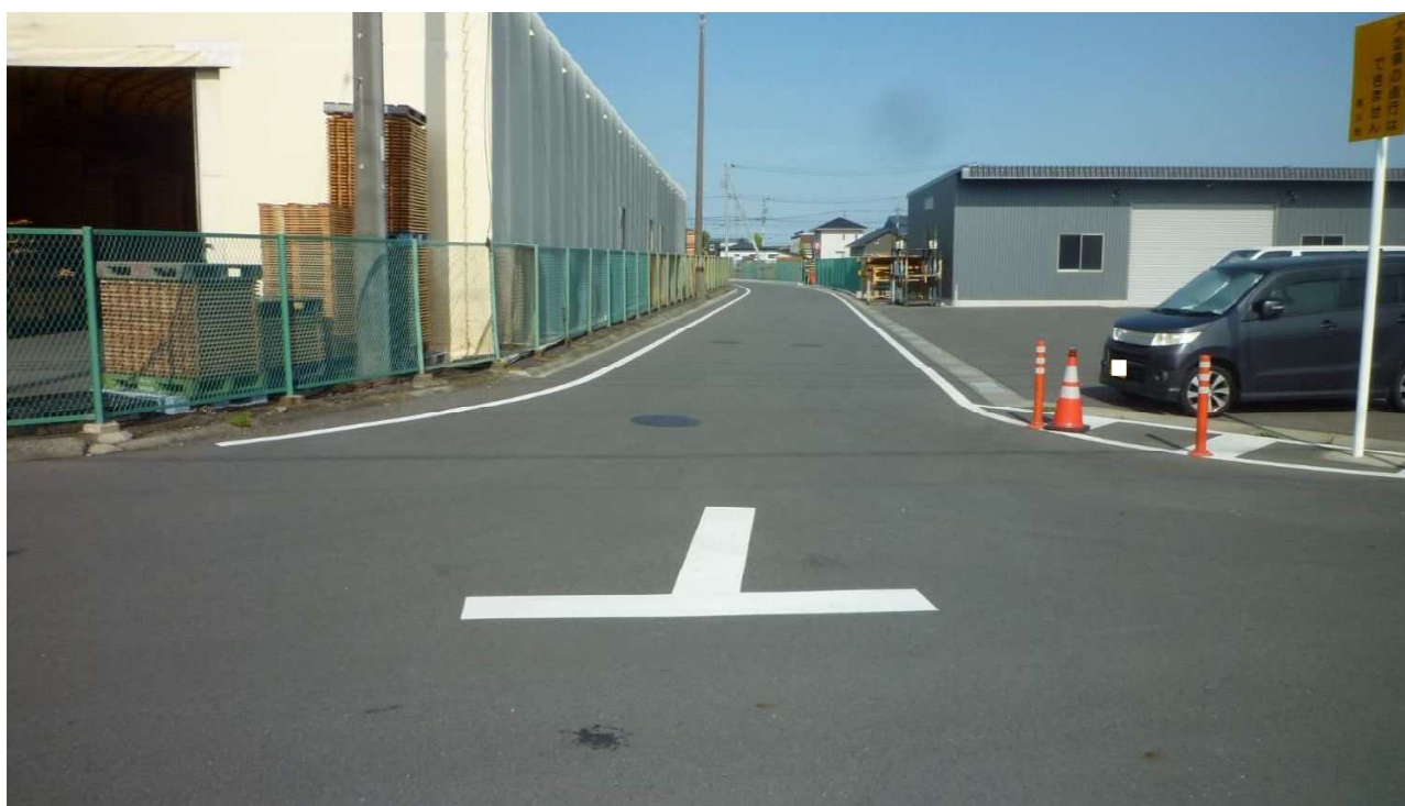
01039 田端 39 号線 現況写真 【終点→中間点】
