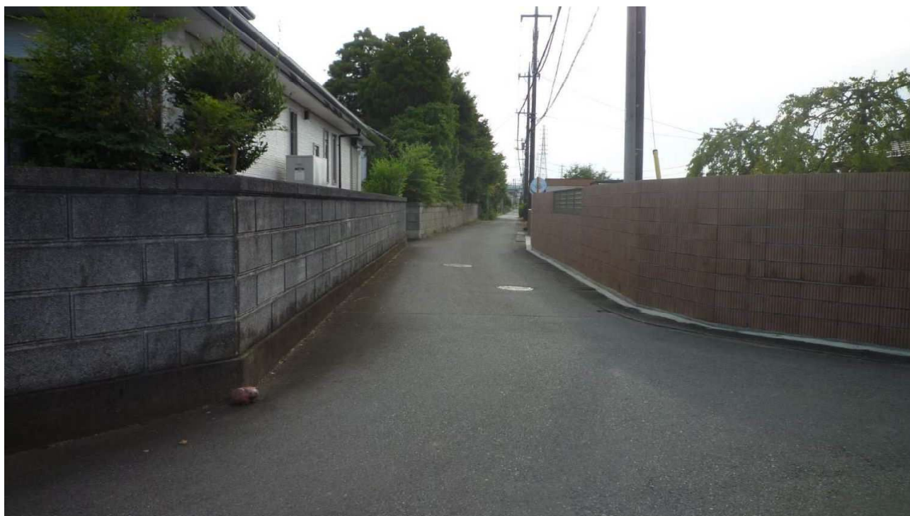
01021 田端 21 号線 現況写真 【起点→中間点】
