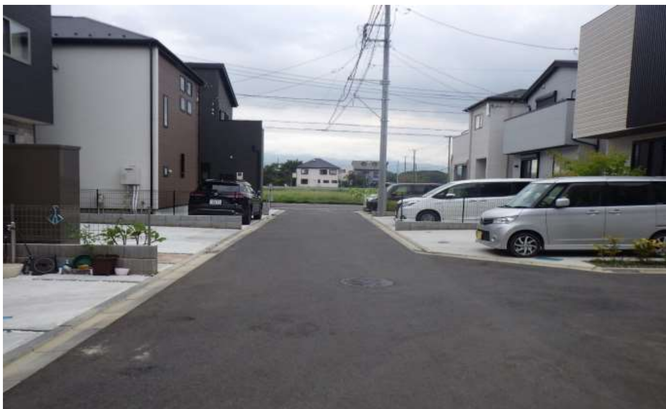
08009 小動 51 号線 現況写真 【終点→起点】
