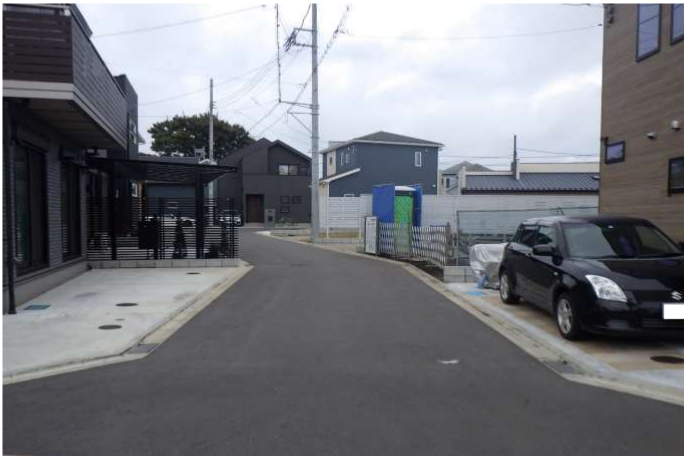
07063 小谷 63 号線 現況写真 【起点→終点】
