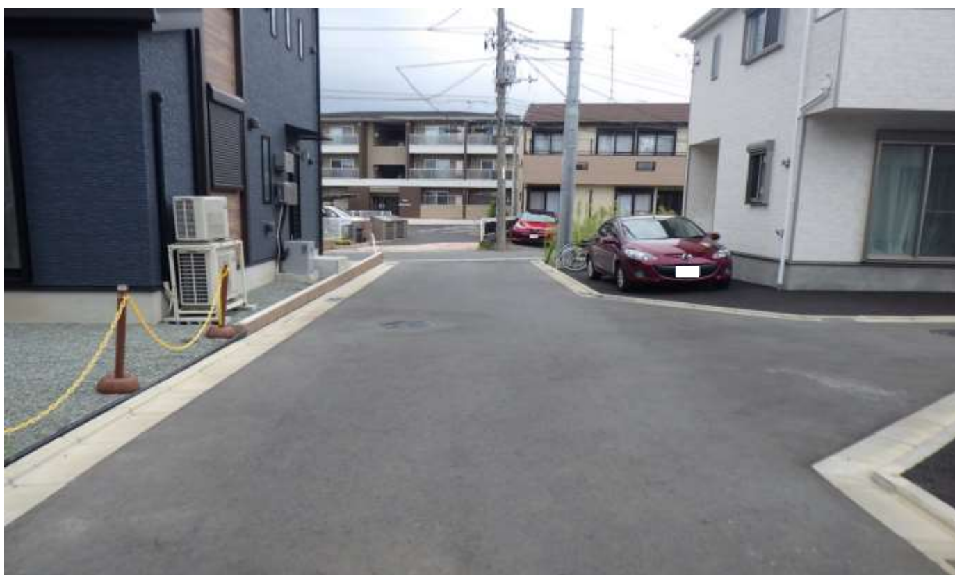
10152 倉見 152 号線 現況写真 【終点→起点】
