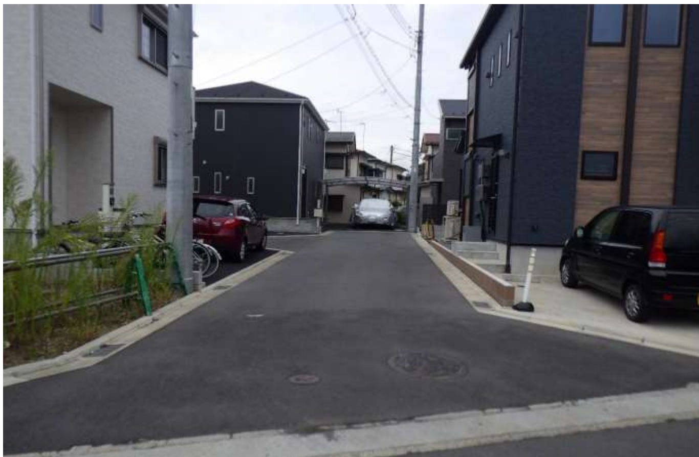
10152 倉見 152 号線 現況写真 【起点→終点】
