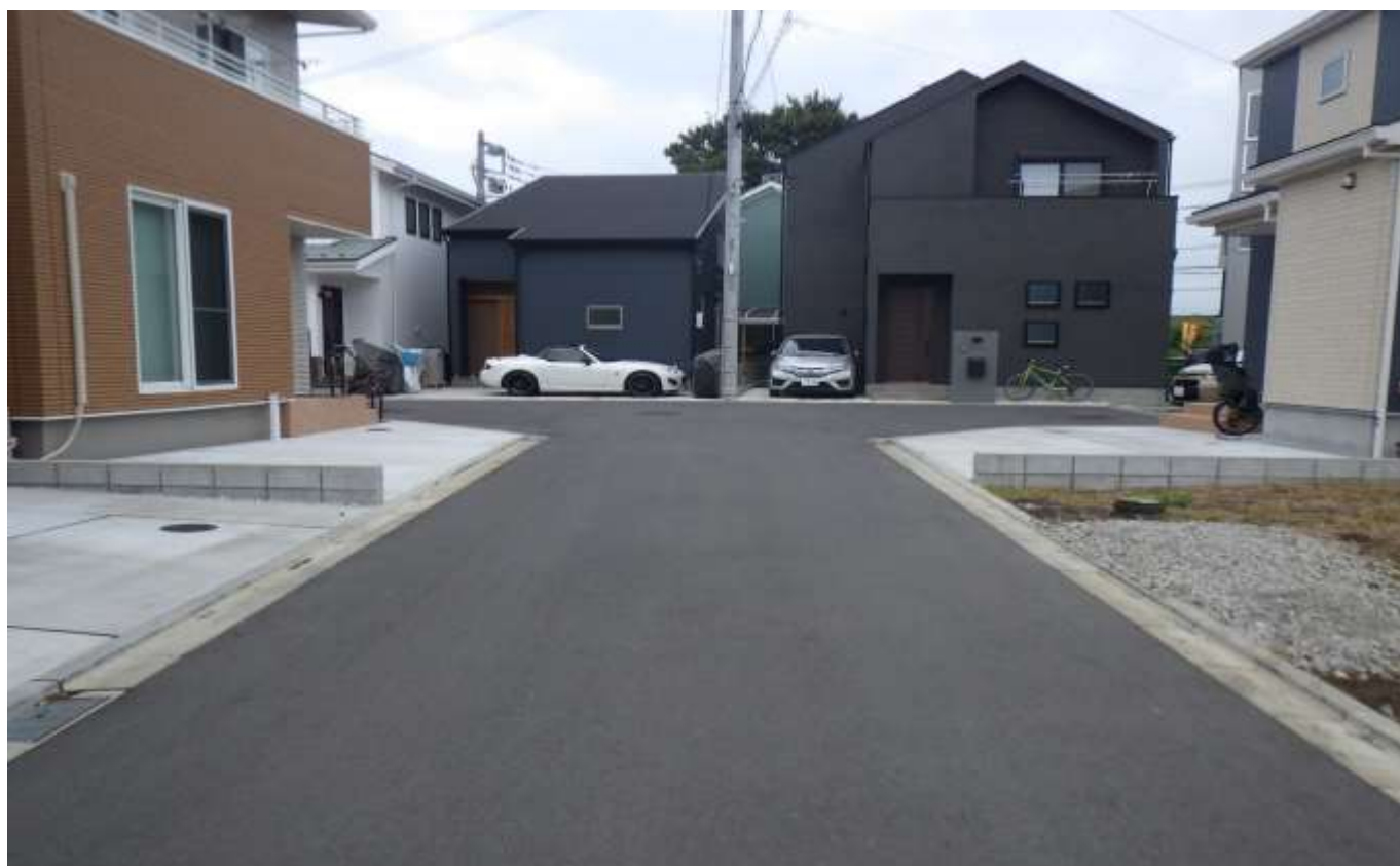
07063 小谷 63 号線 現況写真 【中間点→終点】
