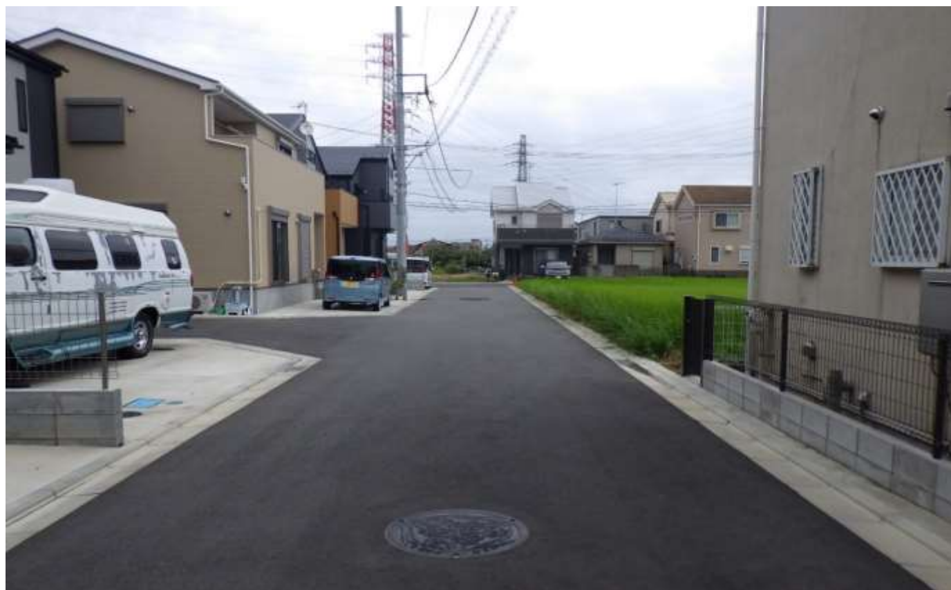
02124 一之宮 124 号線 現況写真 【終点→起点】
