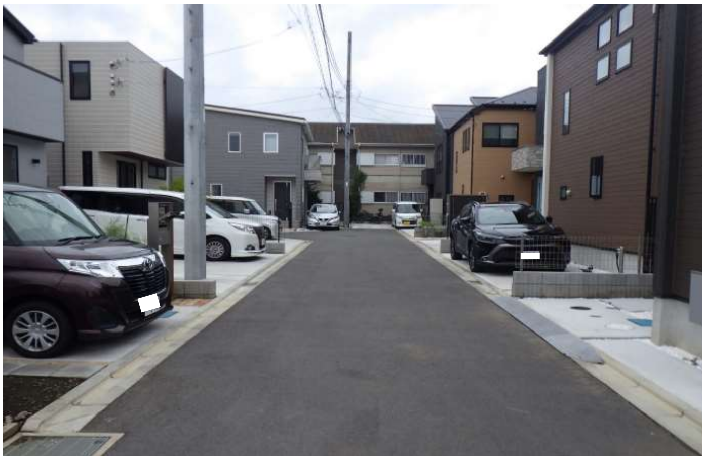
08009 小動 51 号線 現況写真 【起点→終点】
