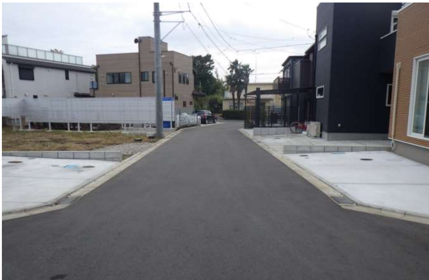
07063 小谷 63 号線 現況写真 【終点→起点】
