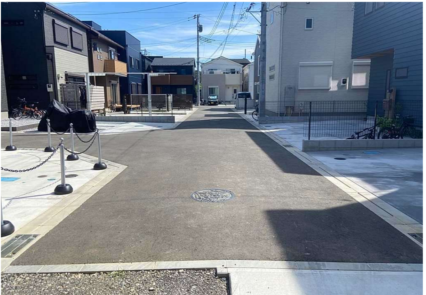
09141 宮山141号線 現況写真 【終点→起点】
