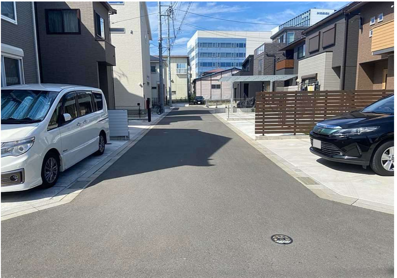
09141 宮山141号線 現況写真 【起点→終点】
