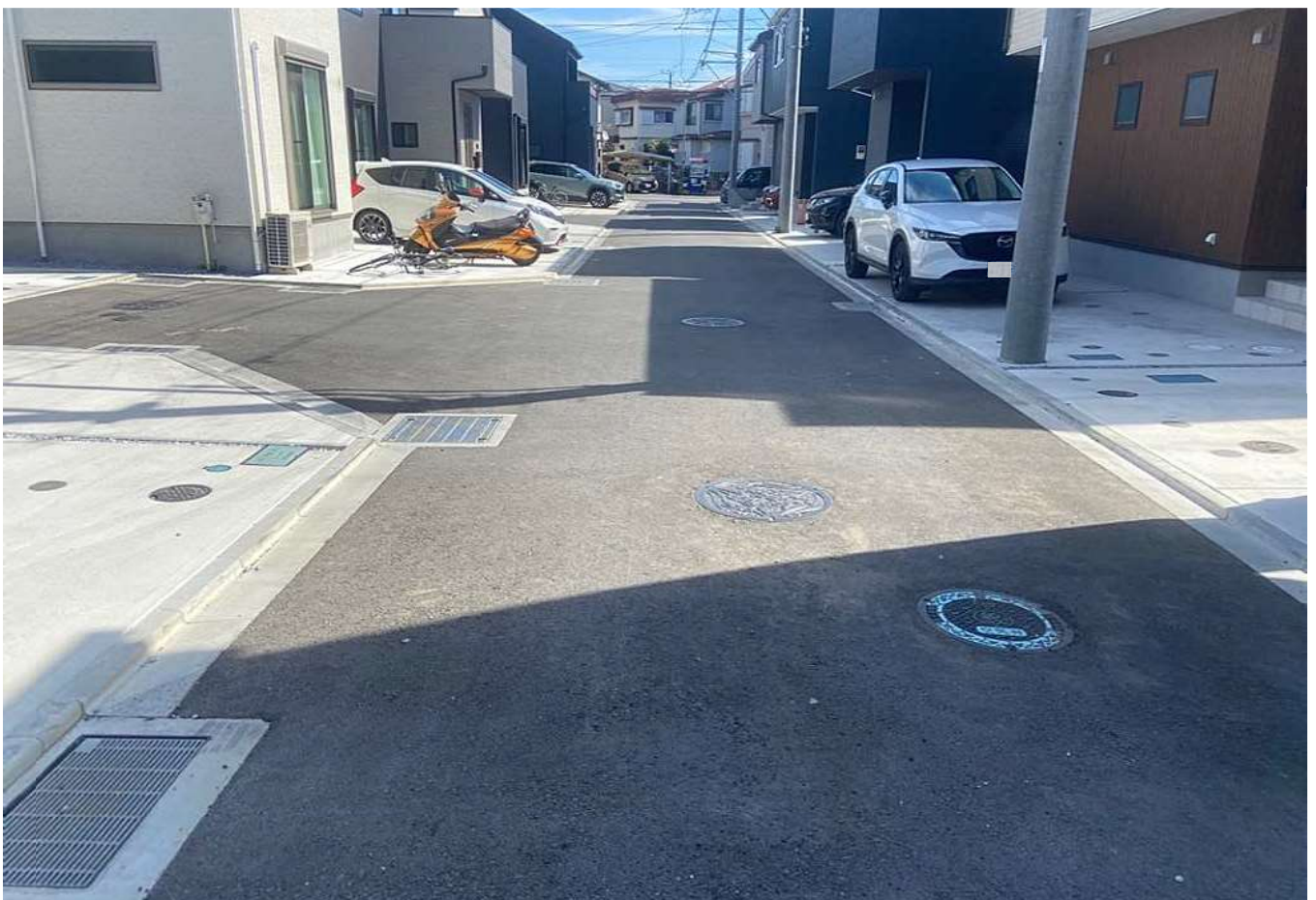
02123 一之宮123号線 現況写真 【終点→起点】
