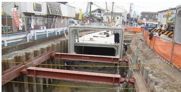
（ボックスカルバートを入れている様子）
