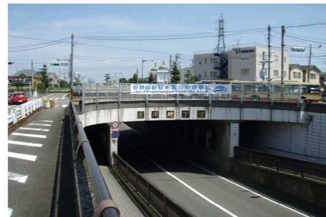
寒川地下道（県道46号線）
