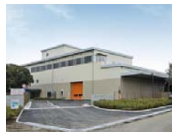
寒川広域リサイクルセンター
