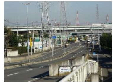
寒川南インターチェンジ周辺
