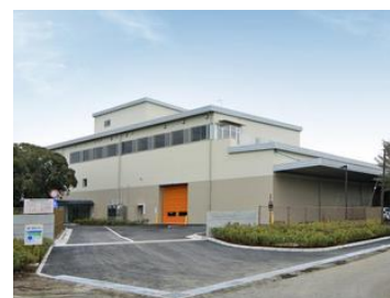
寒川広域リサイクルセンター
