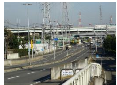
寒川南インターチェンジ周辺
