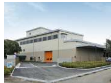
寒川広域リサイクルセンター
