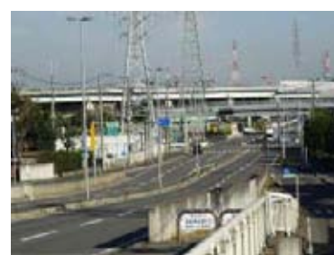
寒川南インターチェンジ周辺
