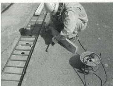
2. 塩ビ管取付 塩ビ管を現場の高さに合わせて切断し、スリットフォームに取り付けます。(ゴムリングで高さの微調整をします。)
