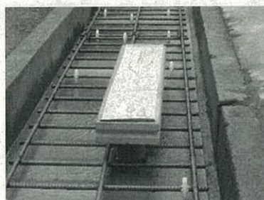
3. スリットフォーム取付 集水するスリット部にコンクリートが入らないようにテープを貼り、KCフォームの孔に塩ビ管を差し込むように取り付けます。
