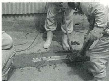
4. コンクリート打設 スリットフォームの下にも、コンクリートが充填されるようにコンクリートを打設します。
