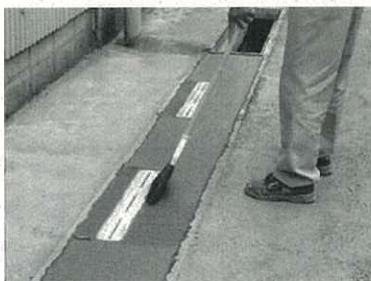
5. 刷毛引き 刷毛引きをして仕上げ、養生します。
