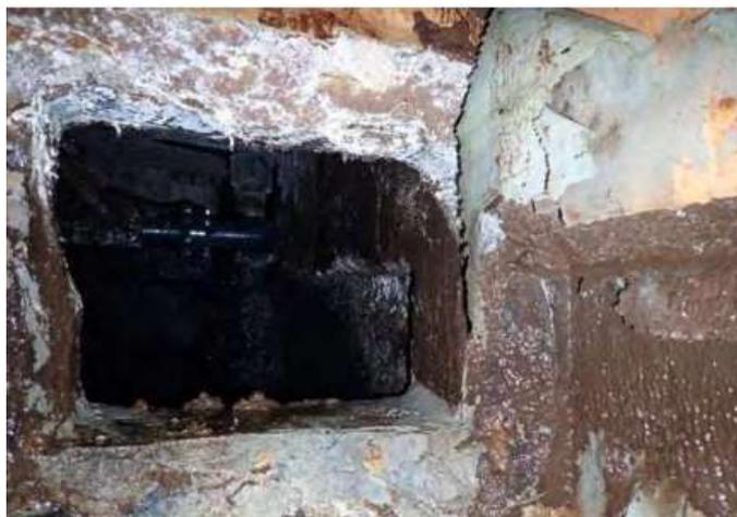
脱気槽防食塗装剥離状況
