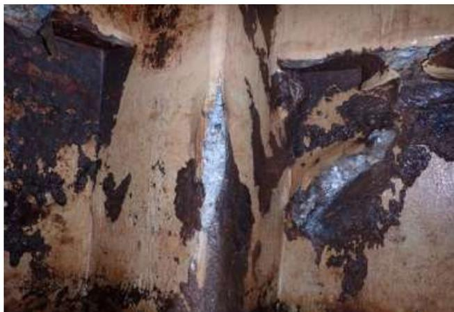
マンホール周辺の防食塗装が剥離しコンクリートの骨材が露出
