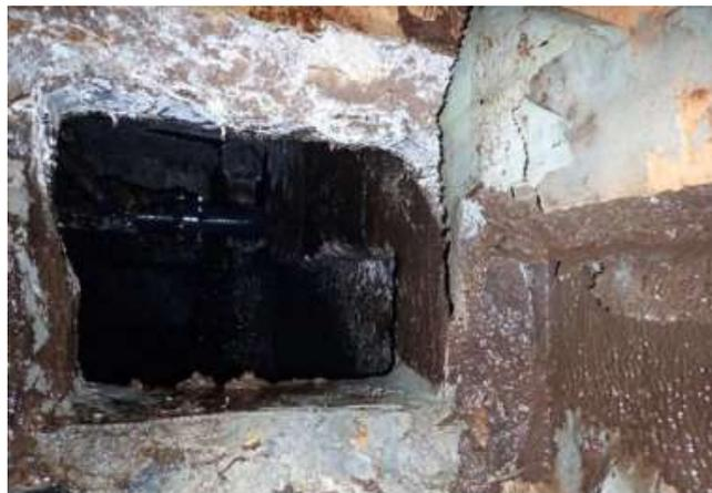
柱・壁・天井の防食塗装が剥離しコンクリートの骨材が露出。
