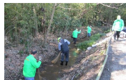
自然循環での復活のために水路を整備
