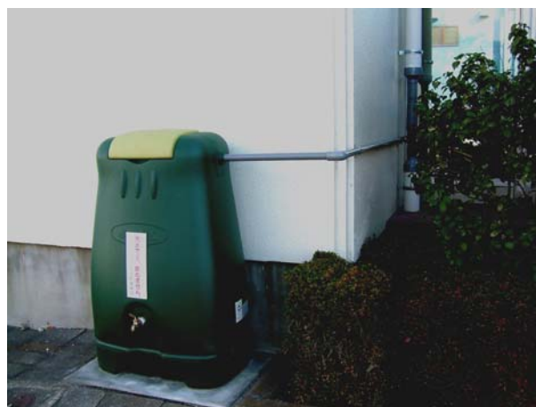
雨水貯留施設
