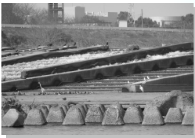
寒川取水堰の魚道
