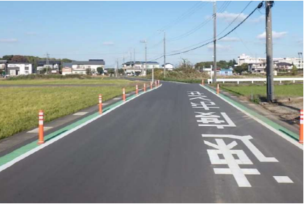
グリーンベルトによる歩車分離
