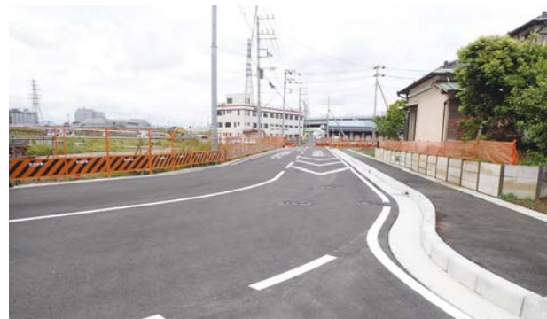
上段：舗装工事前の道路 下段：舗装工事が完了した道路
