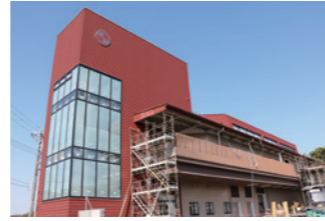
建設中の学校給食センター (9月稼働予定)
