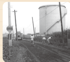
寒川調圧水槽(昭和42年) (資料No.1825-183)
