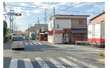
小谷交差点の改良整備
