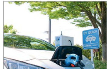
電気自動車用充電器の増設
