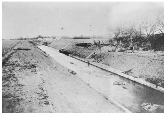
完成した永池川の改修工事（昭和15年）
