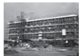
建設中の旭が丘中学校 (昭和46年)
