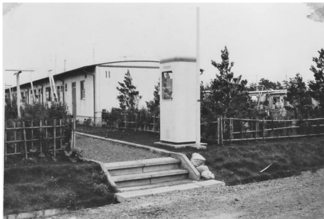
昭和41年の県営住宅
