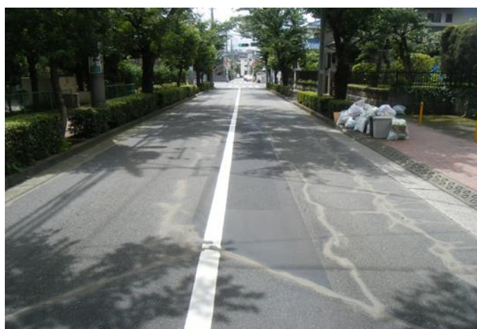
図8 クラックシール工法の例
