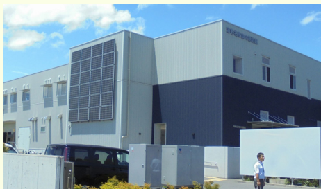
▲太陽光パネル
