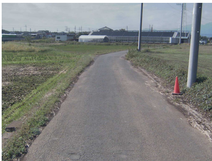
写真- 3.2 分類D 路線におけるひび割れ率 40%の例 2
