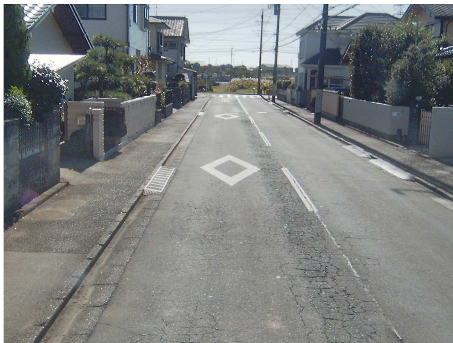
写真- 3.1 分類D 路線におけるひび割れ率 40%の例 1
