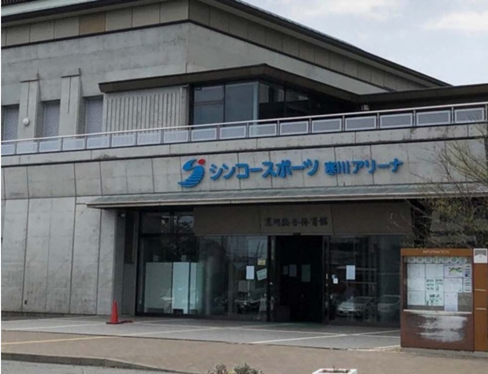
【駐車場側①（正面入り口）】
